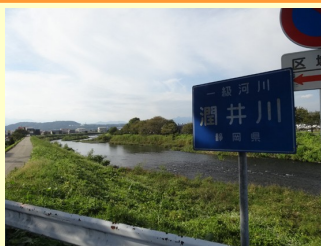
潤井川山橋付近。北関東・東北の豪雨災害を受けて、県が堤等を緊急調査し課題が見つかった。
