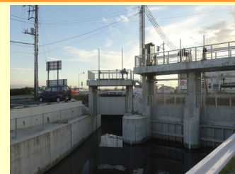
潤井川と清水川の合流地点に設けた排水門。隣接する香西新田など農地を水災害から守るために設置された施設。
