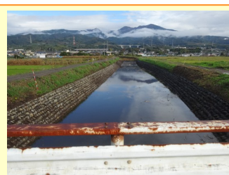
今年度河川整備を終えた春山川だが接続する下流域には葎が生え河床も高い。整備の効果を生かすためにも継続を。
