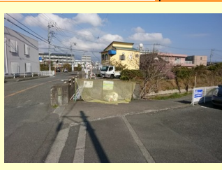
富士市水戸島地区の富士早川改修と老朽化した曙橋の架け替えについて、県と市の意見調整を踏まえ地元へ説明。
