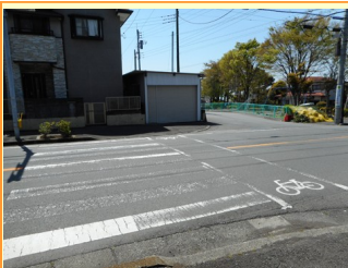
富士見台外周道路の横断歩道。近くの認定こども園に通う園児達を交通事故から守るために、標識等の改修を実施。
