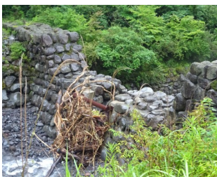
須津川中流部に設置した砂防堰堤は流木・土砂を止めた。
