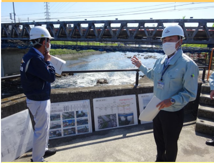
橋台が浸食された黄瀬川橋の復旧状況を、県の担当者から聞く。
