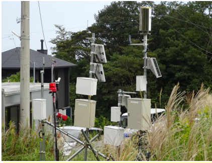
盛土が崩れた跡地は住宅街も隣接している。今後も警戒が続き監視装置を設置。
