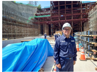
リニア中央新幹線整備における各地の工事の進捗状況を視察。相模原市にある神奈川駅にて。
